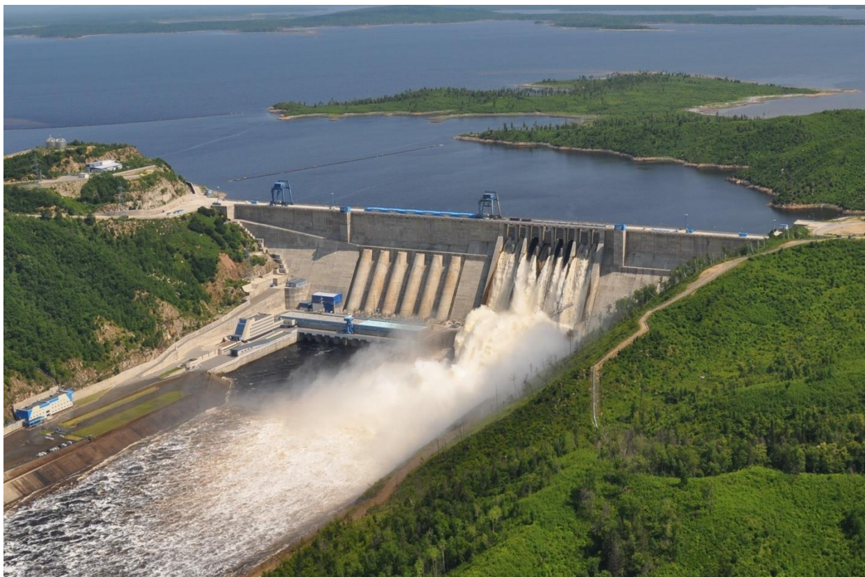
Рис. 8. Бурейская ГЭС с работающим холостым водосбросом
