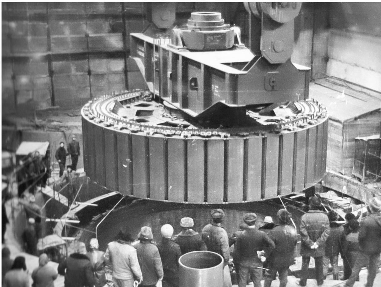
Рис. 32. Установка ротора генератора на Зейской ГЭС
