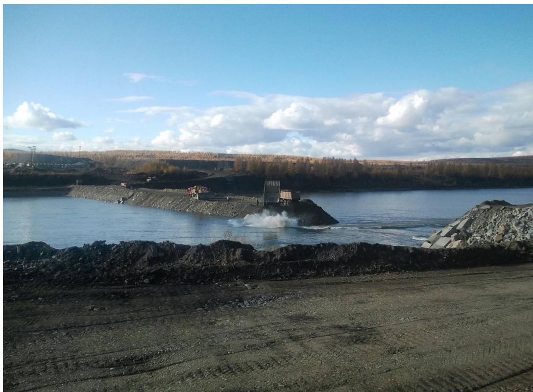
Рис. 26. Перекрытие р. Колымы в створе Усть-Среднеканской ГЭС, создание прорана.
