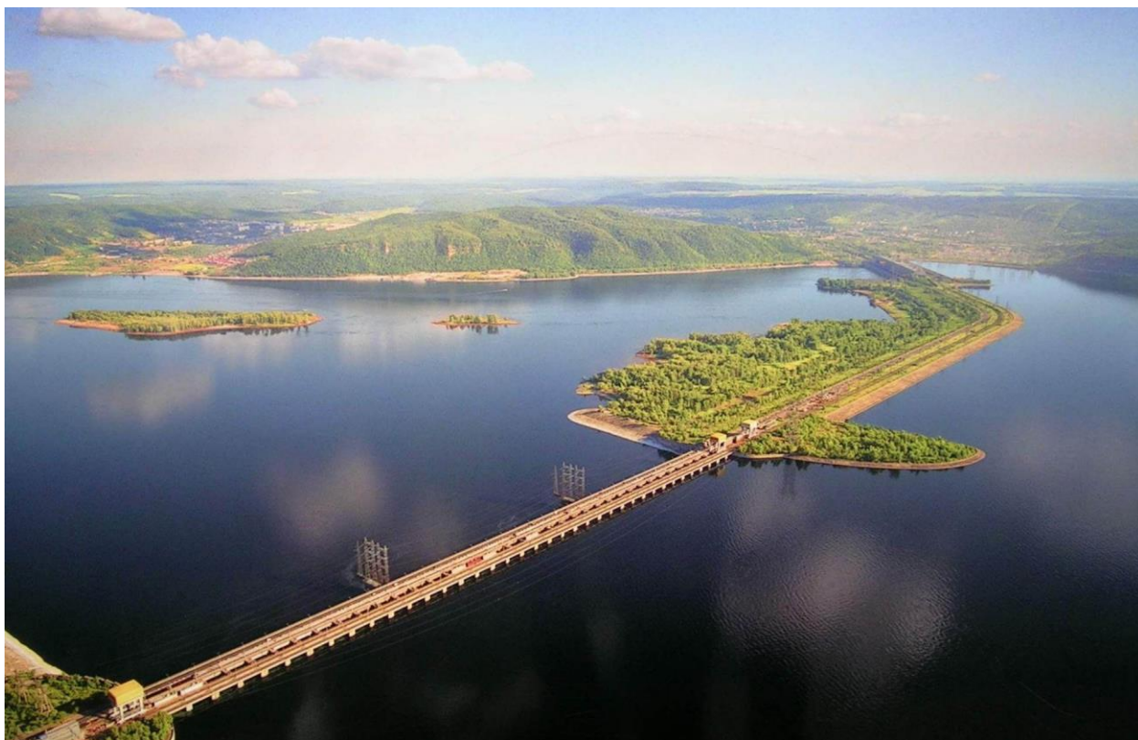
Рис. 9. Панорама Жигулёвской ГЭС
