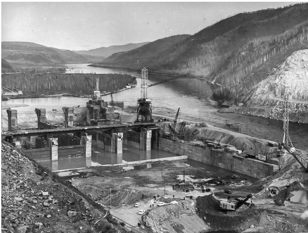
Рис. 21. Подготовка к затоплению котлована I очереди на строительстве Зейской ГЭС
