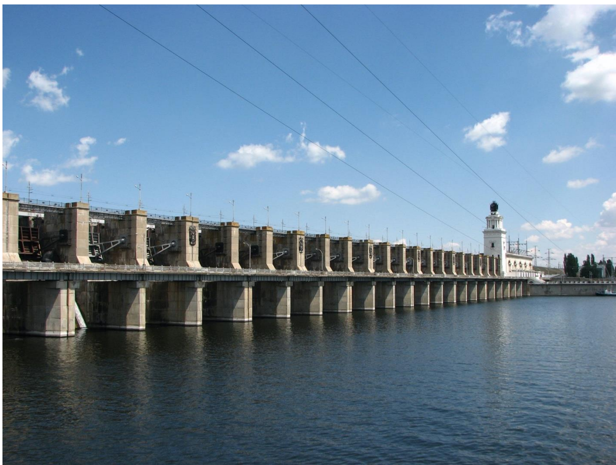
Рис. 25. Водосливная плотина Цимлянской ГЭС
