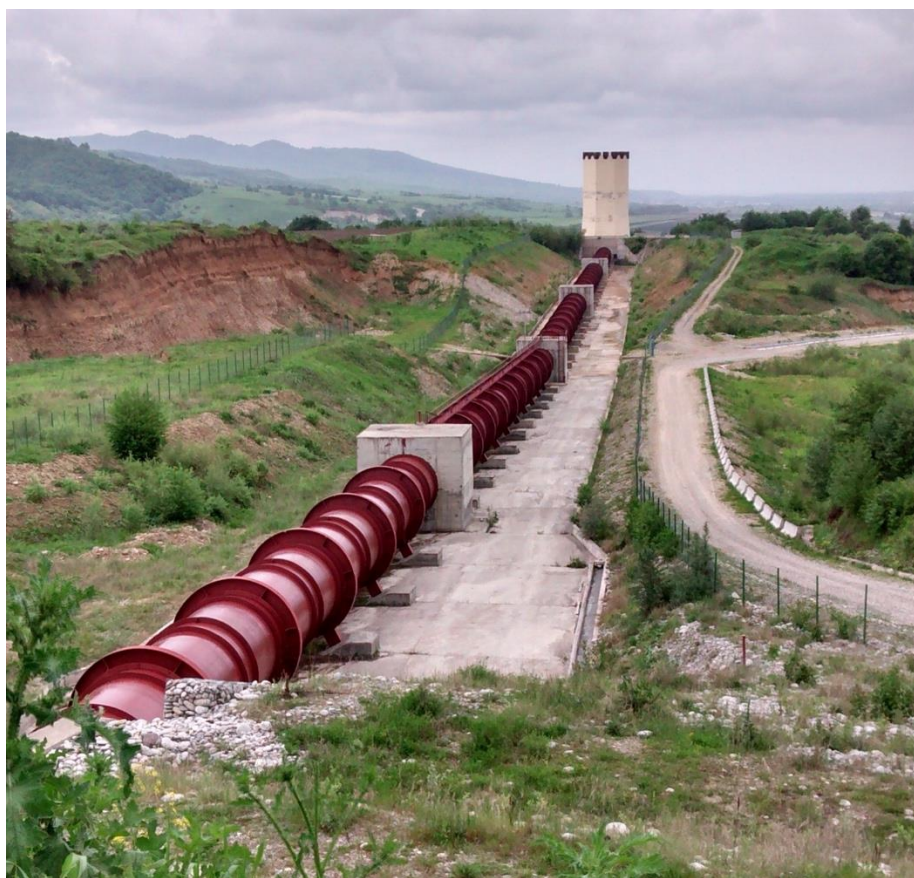
Рис. 7. Напорный водовод и уравнильный резервуар Кашхатау ГЭС
