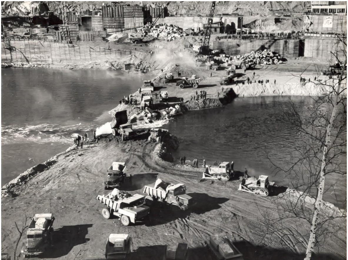
Рис. 27. Перекрытие р. Зеи при строительстве Зейской ГЭС
