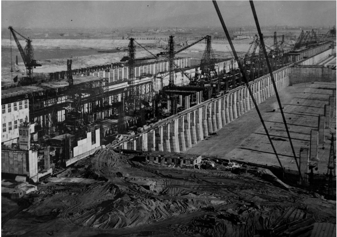
Рис. 11. Строительство Волжской ГЭС
