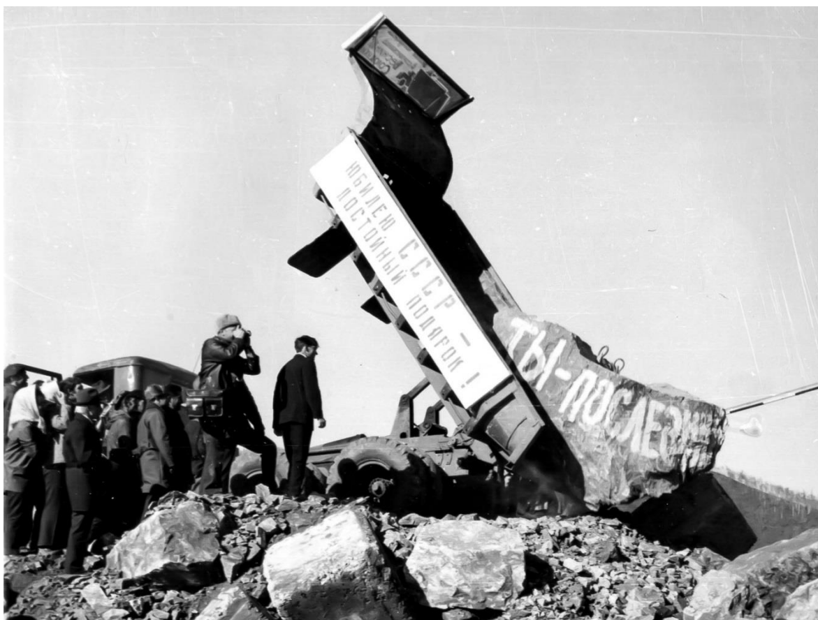
Рис. 28. Завершение перекрытия р. Зеи 13.10.1972 при строительстве Зейской ГЭС
