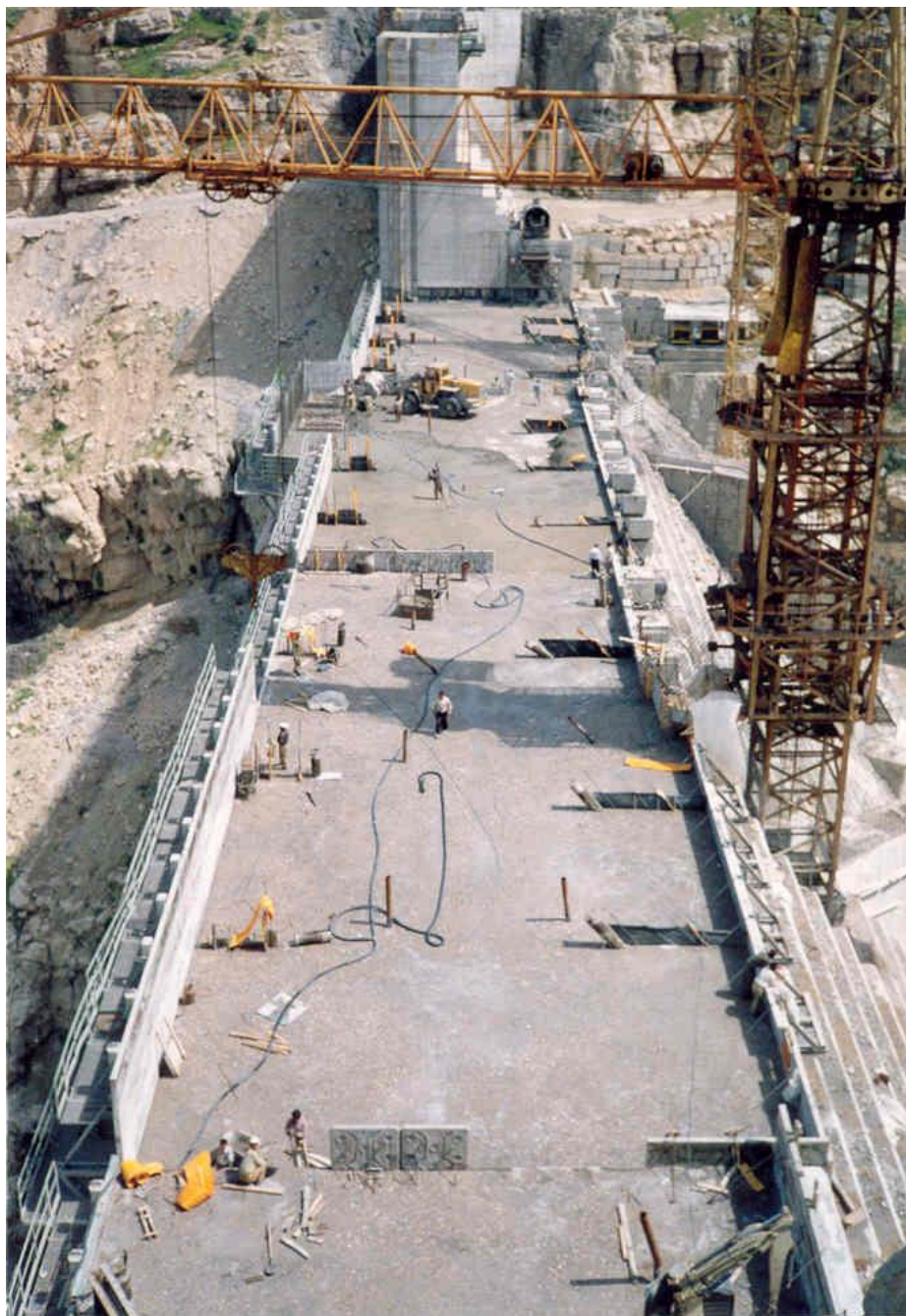
Рис. 30. Строительство плотины Коусар (Иран) высотой 144 м
